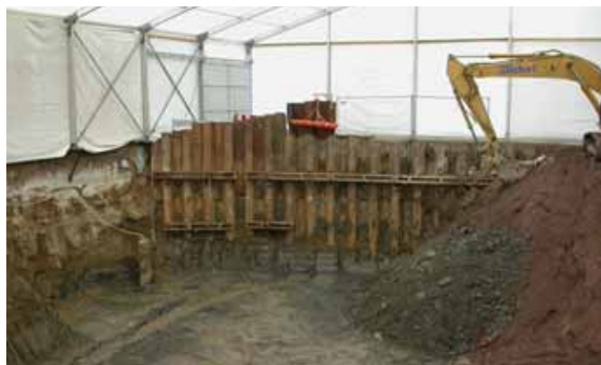
Aushub von belastetem Bodenmaterial (Altlast)
