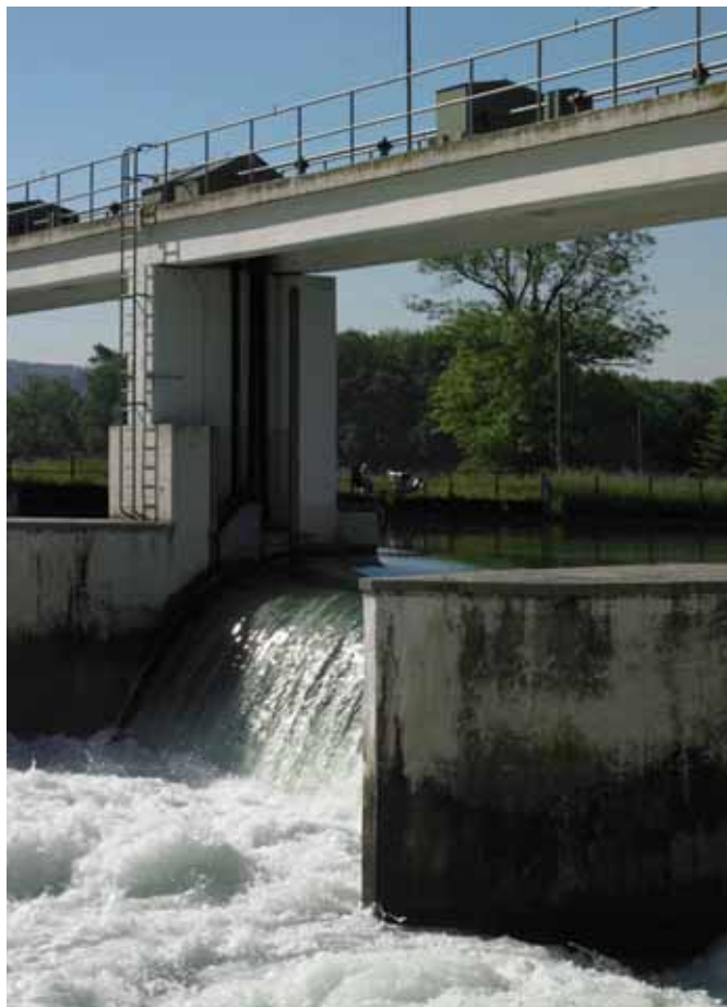
Staustufe der Limmat beim Elektrizitätswerk Dietikon ZH
