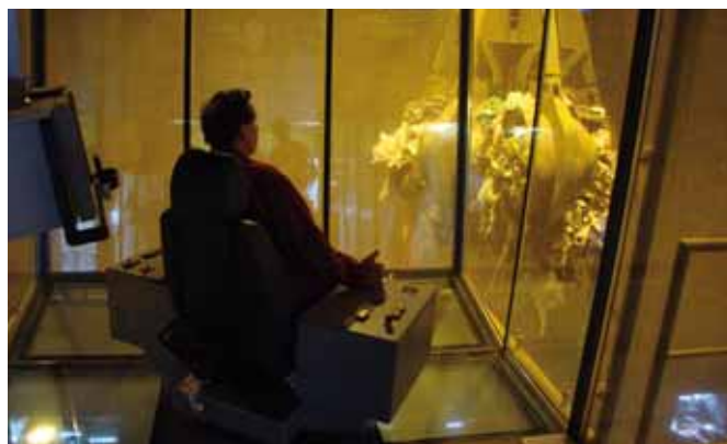
Beladen des KVA-Verbrennungsofens
