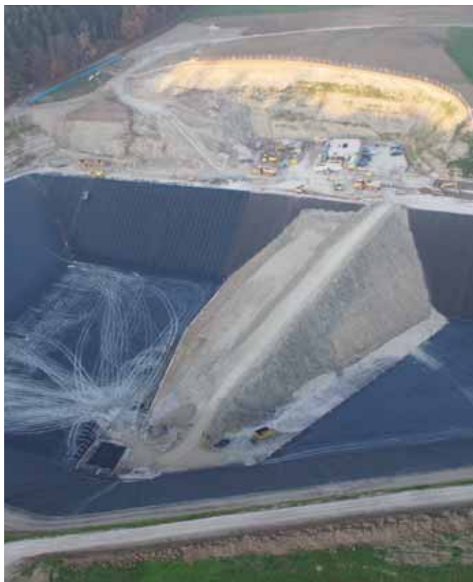
Kombinierte Deponie Häuli in Lufingen ZH in der Einbauphase
